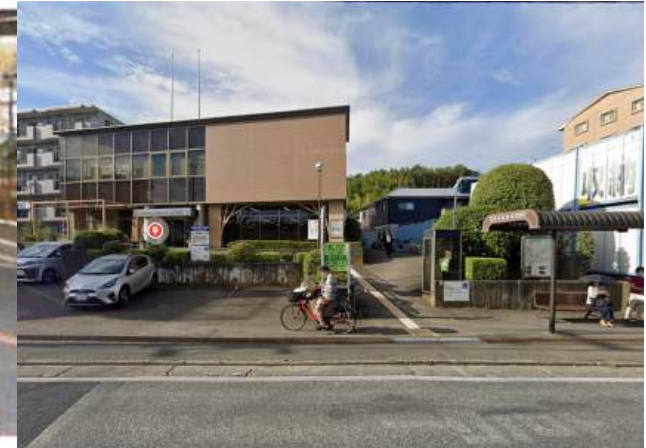
現在の向丘出張所とバス停付近の様子 令和8年度に工事完了を予定。
