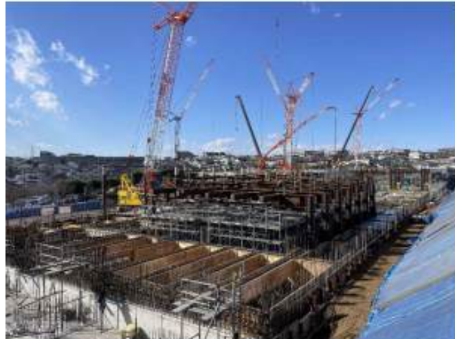
昭和大学：令和8年1月時点の工事の様子
